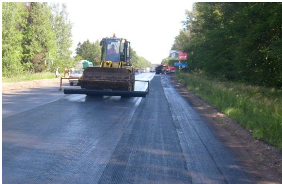
Рисунок 4 – Пример укладки геосетки на основание
