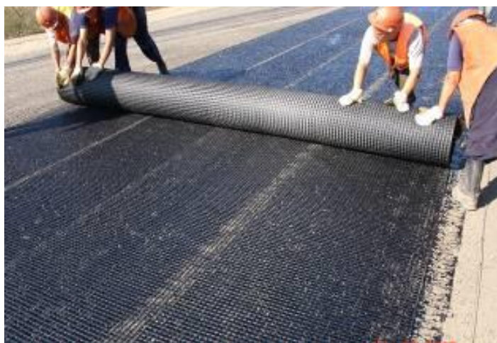
Рисунок 5 – Укладка геосетки вручную
